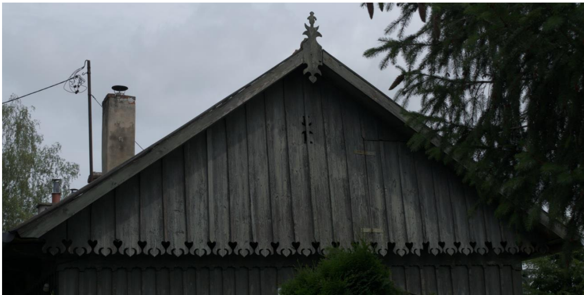
Rys. 5 i 6. Przykłady tradycyjnych wycięć ciesielskich na szalunkach domów z terenu gminy Pleśna i Ciężkowice. Fotografie wykonane przez Mateusza Reczek.
