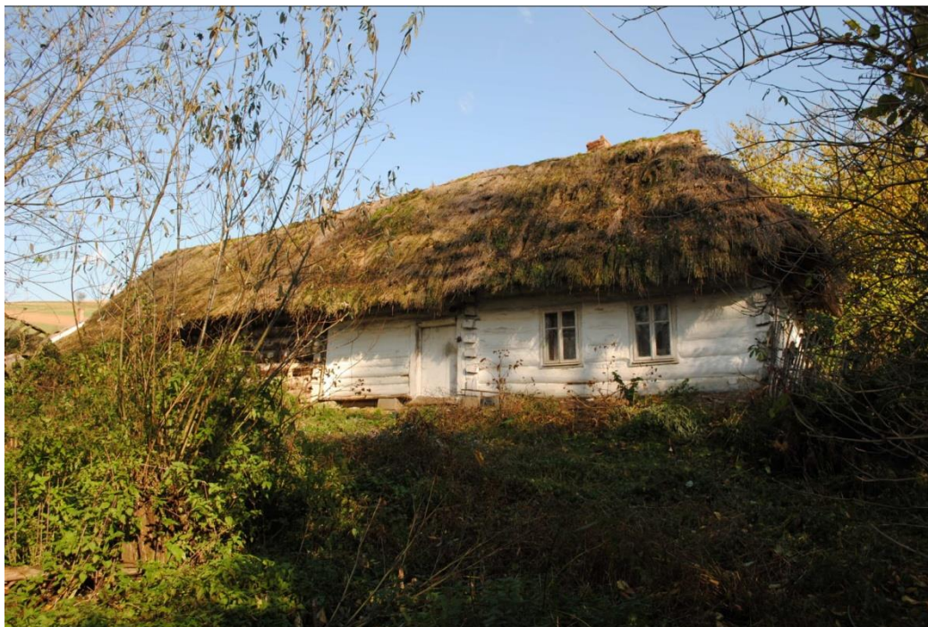
Rys.2. Przykłady tradycyjnego budownictwa z terenu gminy Ciężkowice, na fotografiach nieistniejąca chata w Zborowicach. Źródło: Gminna Ewidencja Zabytków Gminy Ciężkowice.
