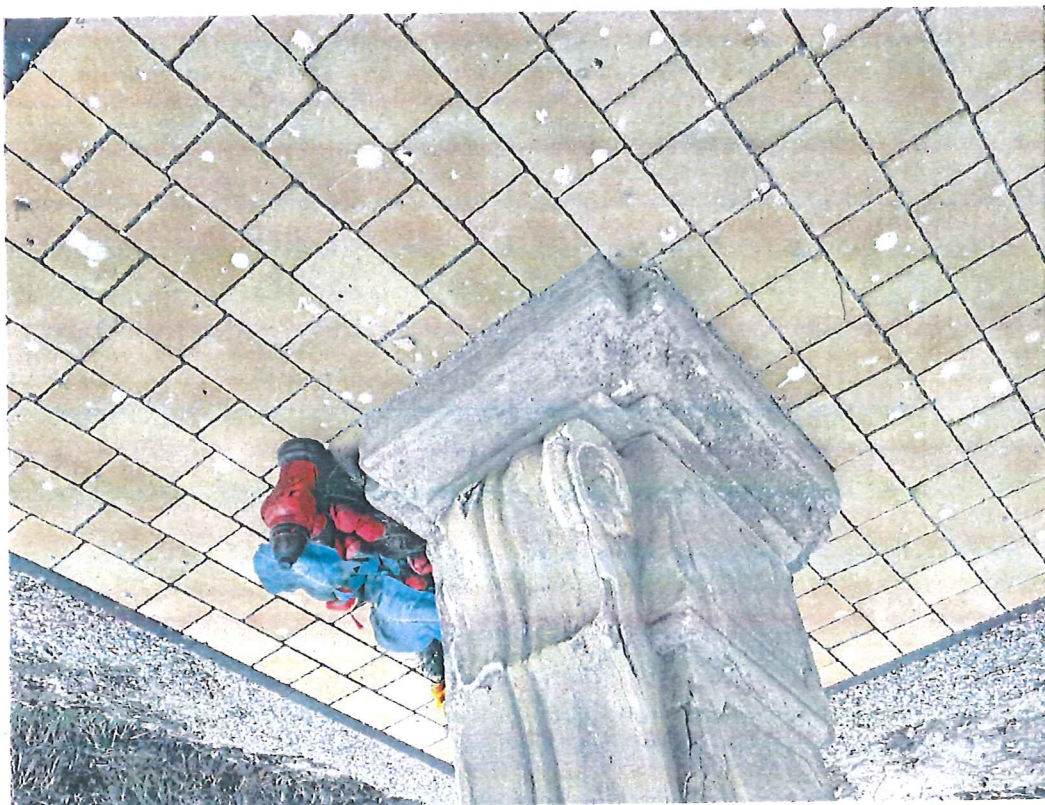
Fot. 15. Kapliczka z figurą Św. Jana Nepomucena w Więckowicach, gmina Wojnicz, program prac konserwatorskich. Dolna część postumentu, widok od strony wschodniej na wolutę i cokół, obrazujący zakres destrukcji uzupełnień.
