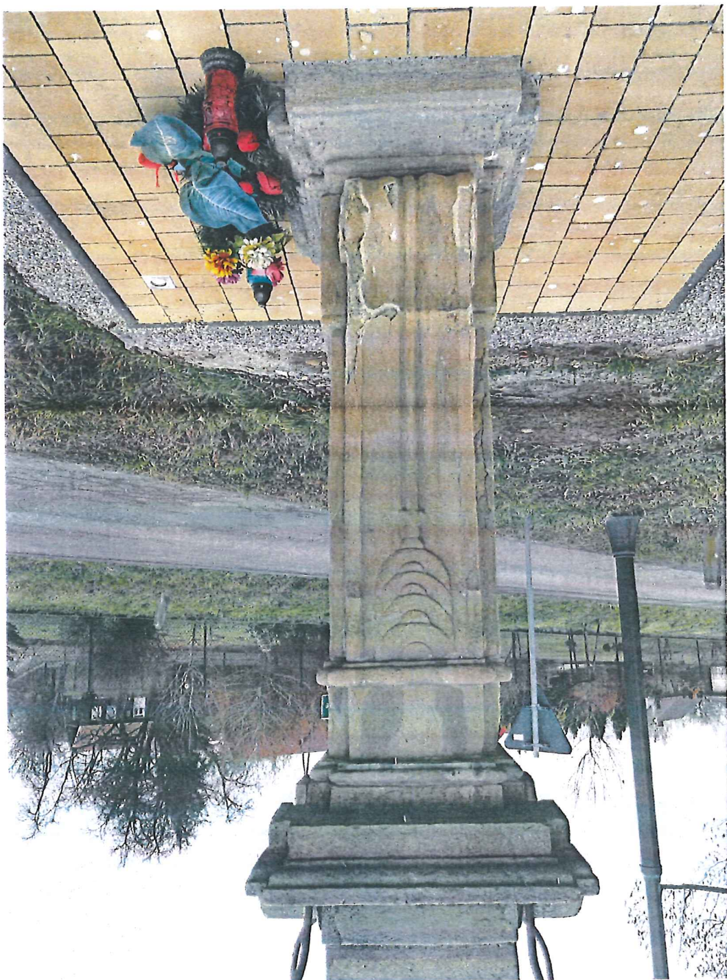
Fot. 8. Kapliczka z figurą Św. Jana Nepomucena w Włéckowicach, gmina Wojnicz, program prac konserwatorskich. Postument, ściana południowo wschodnia, widok ścianką postumentu, na wolutę i cokół, obrazujący zakres destrukcji uzupełnień.
