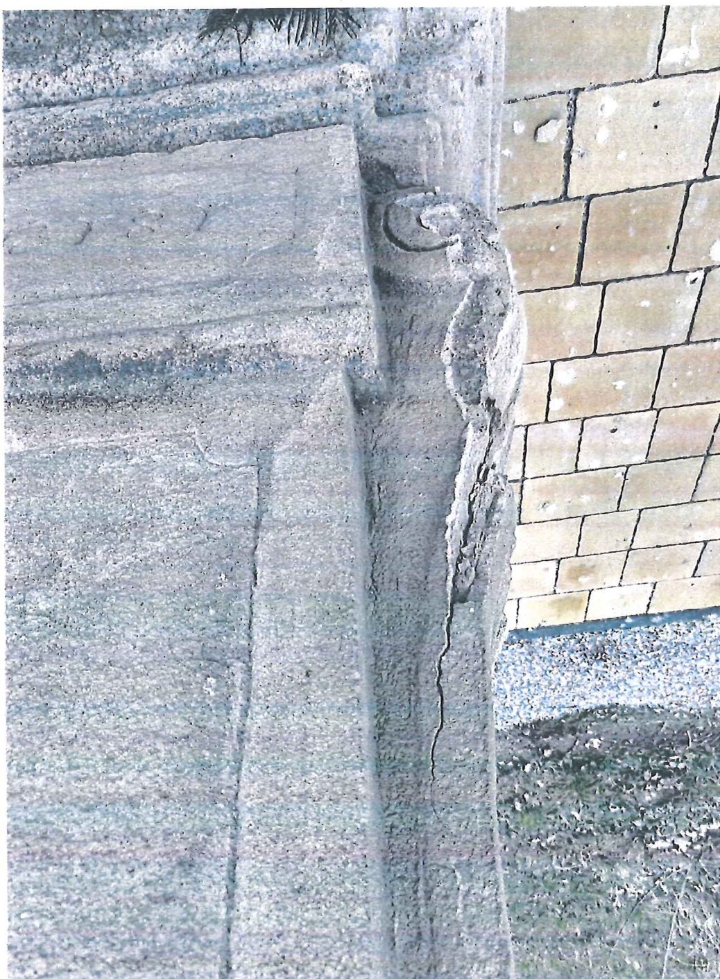
Fot. 17. Kapliczka z figurą Św. Jana Nepomucena w Włóczkach, gmina Wojnicz, program prac konserwatorskich. Dolna część postumentu, widok narożnika południowego. Widoczne wgłębne odspojenia uzupełnionych na wolucie i zaczerpnięte lica kamienia na sokole.
