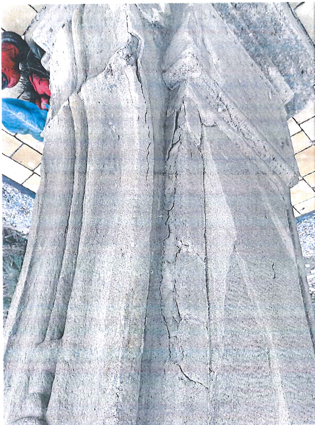
Fot. 18. Kapliczka z figurą św. Jana Nepomucena w Włęczkowicach, gmina Wojnicz, program prac konserwatorskich. Dolna część postumentu, ujęcie detaliczne na narożnik od strony wschodniej. Widoczne wgłębne odspojenia uzupełnień na wolicie i zacerznienie lica kamienia na sokole.
