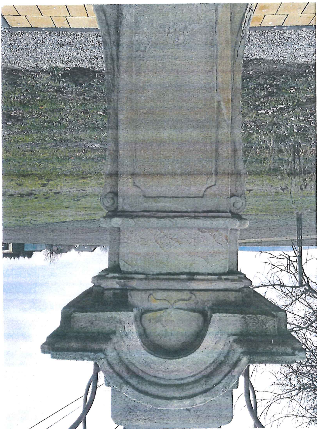
Fot. 7. Kapliczka z figurą Św. Jana Nepomucena w Więckowicach, gmina Wojnicz, program prac konserwatorskich. Postument, ściana północno wschodnia, część górna. Aktualny stan zachowania łąca kamienia naturalnego i uzupełnień.
