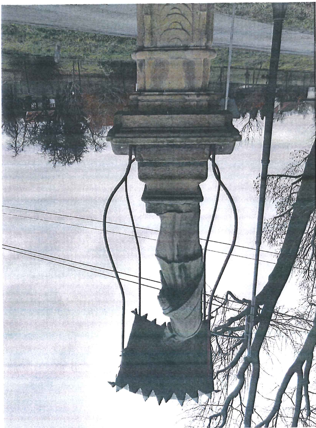
Fot. 9. Kapliczka z figurą św. Jana Nepomucena w Włoczkowicach, gmina Wojnicz, program prac konserwatorskich. Postument, ściana południowo wschodnia, część górna. Aktualny stan zachowania łąca kamienia naturalnego i uzupełnień.
