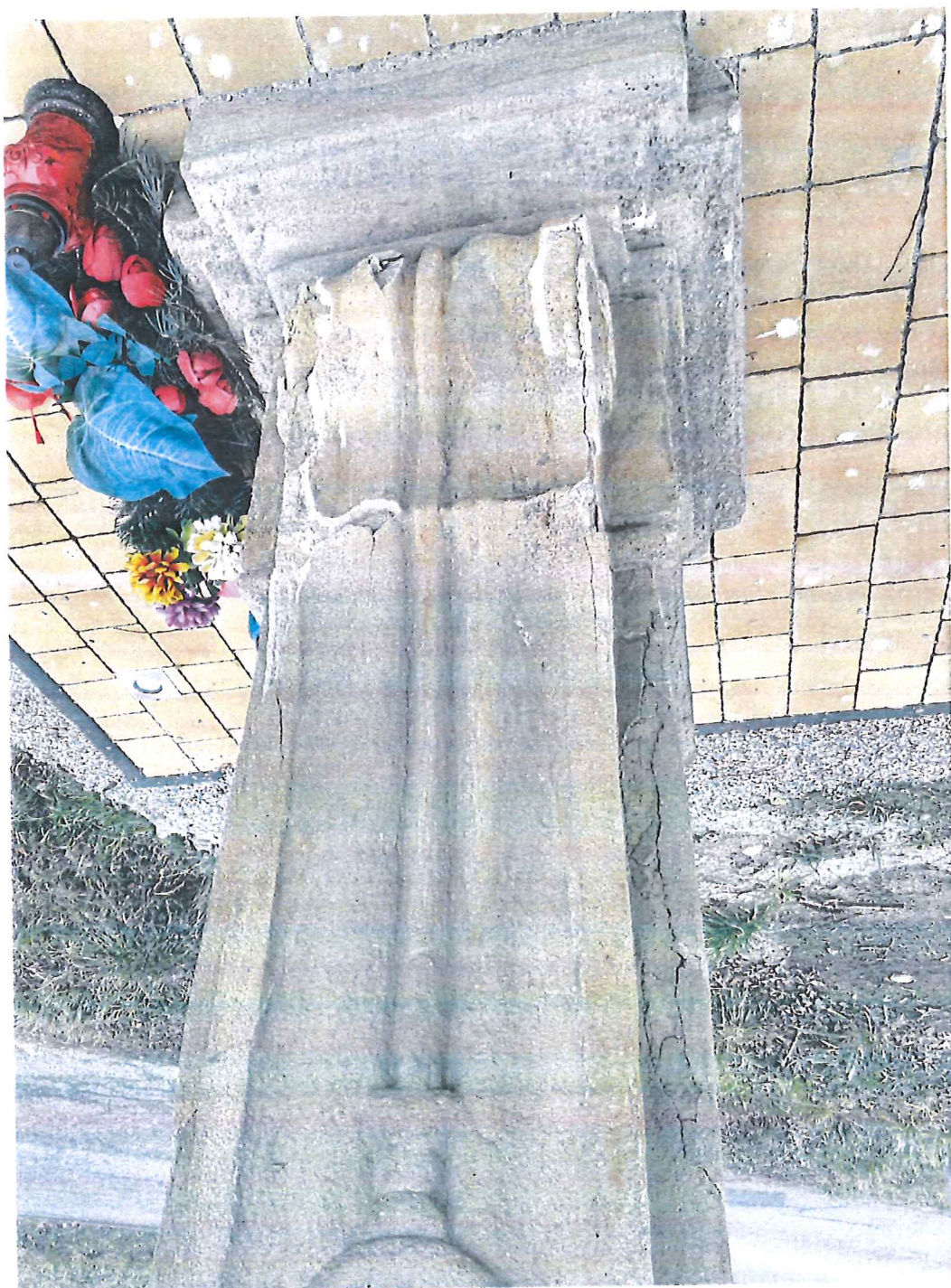
Fot. 14. Kapliczka z figurą Św. Jana Nepomucena w Więckowicach, gmina Wojnicz, program prac konserwatorskich. Dolna część postumentu, widok od strony południowo zachodniej na wolutę i cokół, obrazujący zakres destrukcji uzupełnień.
