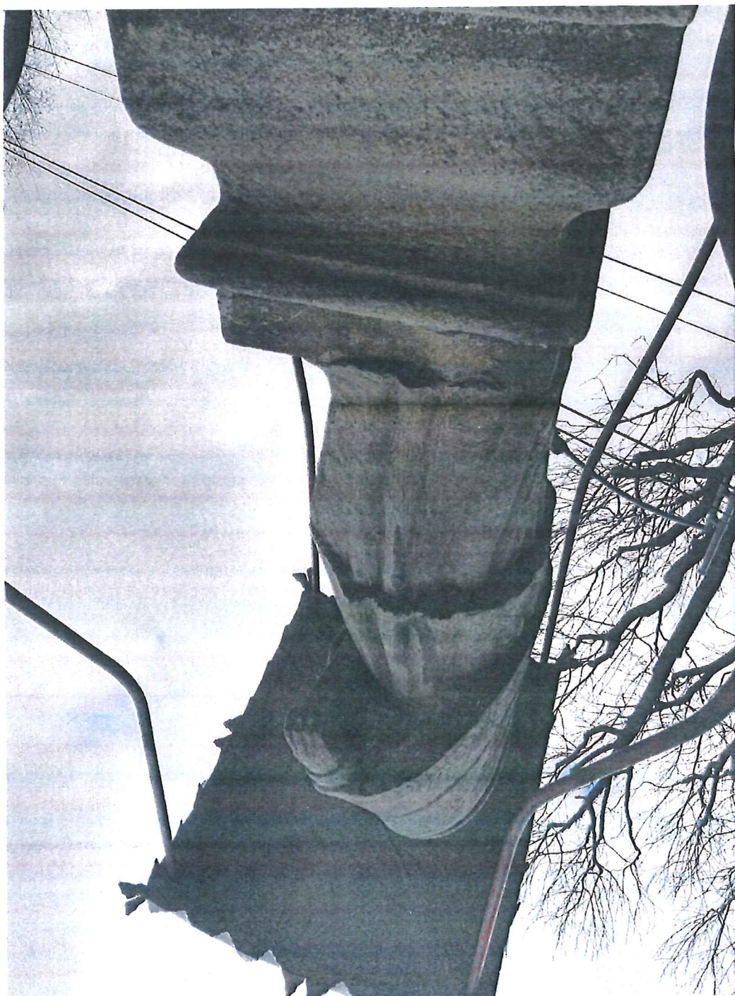
Fot. 11. Kapliczka z figurą Św. Jana Nepomucena w Wiekowicach, gmina Wojnicz, program prac konserwatorskich. Kompozycja figury Św. Jana Nepomucena, widok od strony południowo-wschodniej:: figura, cokolik pod figurę. Aktualny stan zachowania lica kamienia naturalnego i uzupełnień.
